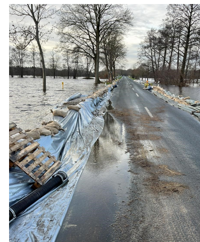
Mit Sandsäcken und Hochleistungspumpen konnten die Kameraden der Feuerwehr die L59 im Schichtbetrieb freihalten und damit den Zugang nach Steinbild sichern. (Foto: Jens Sievers)
